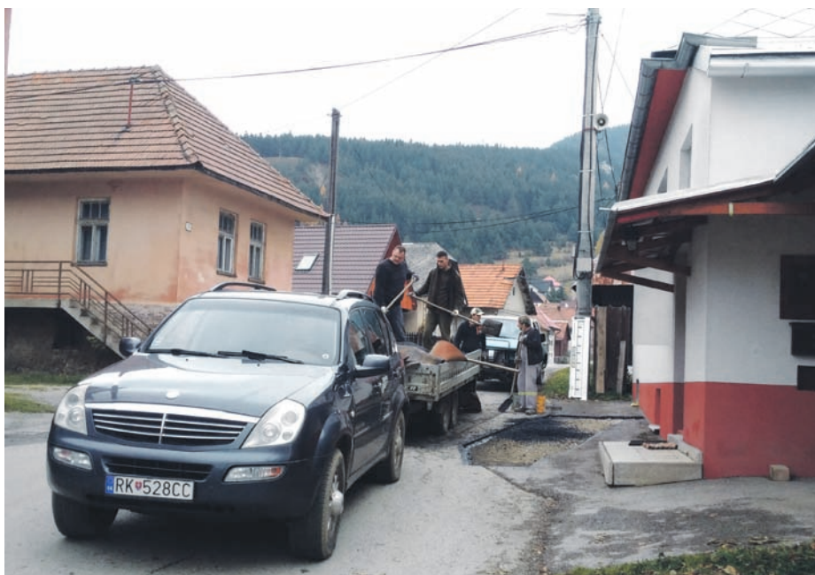
Svojpomocná oprava výtlkov.
