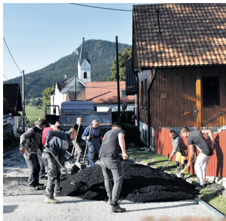
Asfaltovanie obecných ciest
